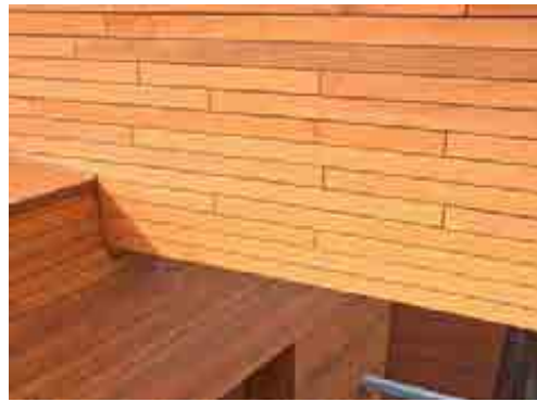
Afbeelding 4 Gunstig: 3 lagen kleurbeits op fijnbezaagd oppervlak.
