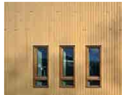
Afbeelding 2 Gevelbekleding in "wildverband".
