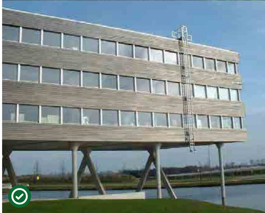
Afbeelding 13 + 14 Voor een gelijkmatige vergrijzing is het noodzakelijk dat de gevel gelijkmatig en voldoende aan weer en wind blootstaat.
