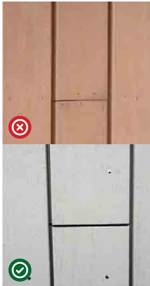
Afbeelding 7 + 8 Bevestig de delen aan de uiteinden met één ringnagel met bolle kop of schroef (lenskop of bolkop).
