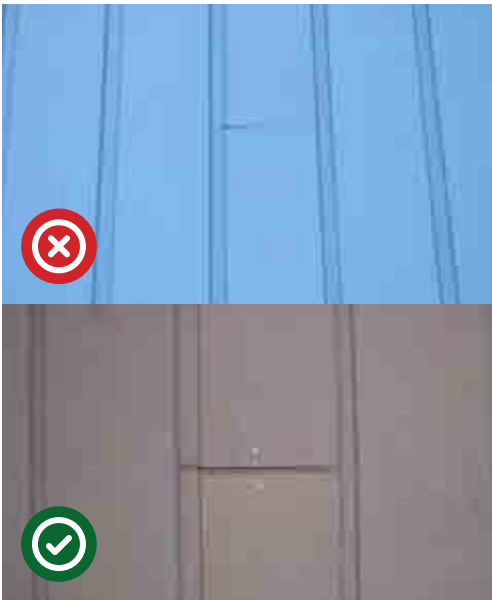
Afbeelding 9 + 10 Bij ontmoetingen 7-10 mm ruimte vrijhouden tussen de delen.
