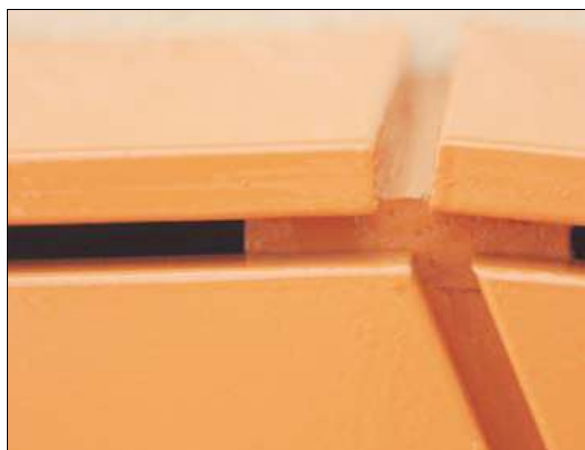
Afbeelding 1. Voorbeeld van goed afronden, ventileren en dilateren van plaatmateriaal.
